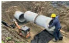
Le chantier de la Route 275 consiste à remplacer l'ancienne chaussée par une autre, tout en prenant soin d'enlever la terre végétale pouvant endommager à long terme la chaussée. Les fossés seront nettoyés et de nouveaux ponceaux seront installés afin de permettre l'évacuation de l'eau. La structure de la chaussée sera surélevée pour se protéger des effets du gel.
